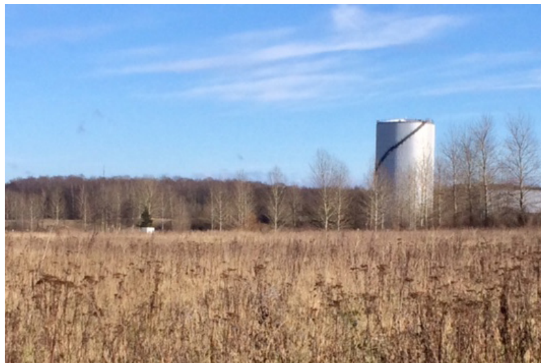
Et kig fra lokalplanområdet mod Overdrevsvejen.
