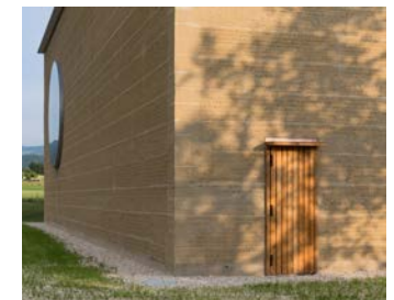
Kräuterzentrum, Schweiz Herzog & de Meuron Enkel industriel bygningskrop gjort levende med store "glughuller". Bygningen er opført med et unikt bæredygtigt facademateriale bestående af lokal lerjord, som også giver de store enkle facader struktur og farvespil i varme nuancer.
